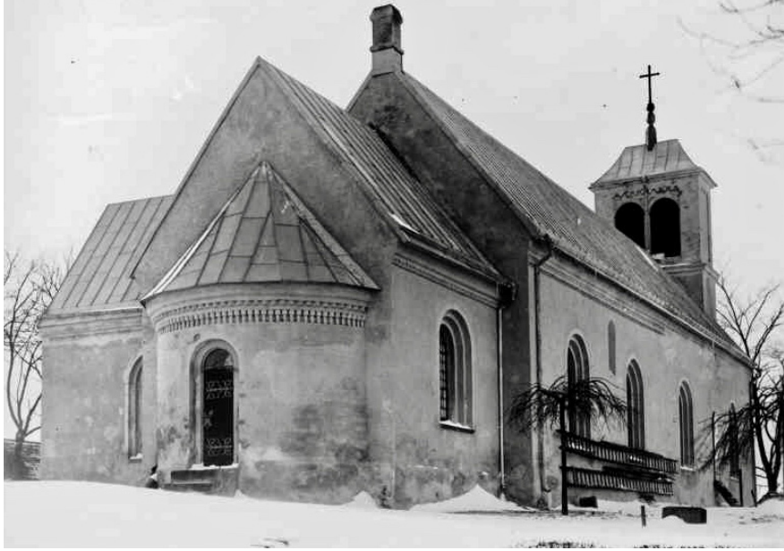
Kyrkan från nordöst. Okänt årtal, men sannolikt under 1900-talets två första decennier. Fasaderna tycks vara slätputsade och är avfärgade i gult. Notera även att ab- sidens ingång i öster ännu finns kvar. Bild från ATA, okänd fotograf.
