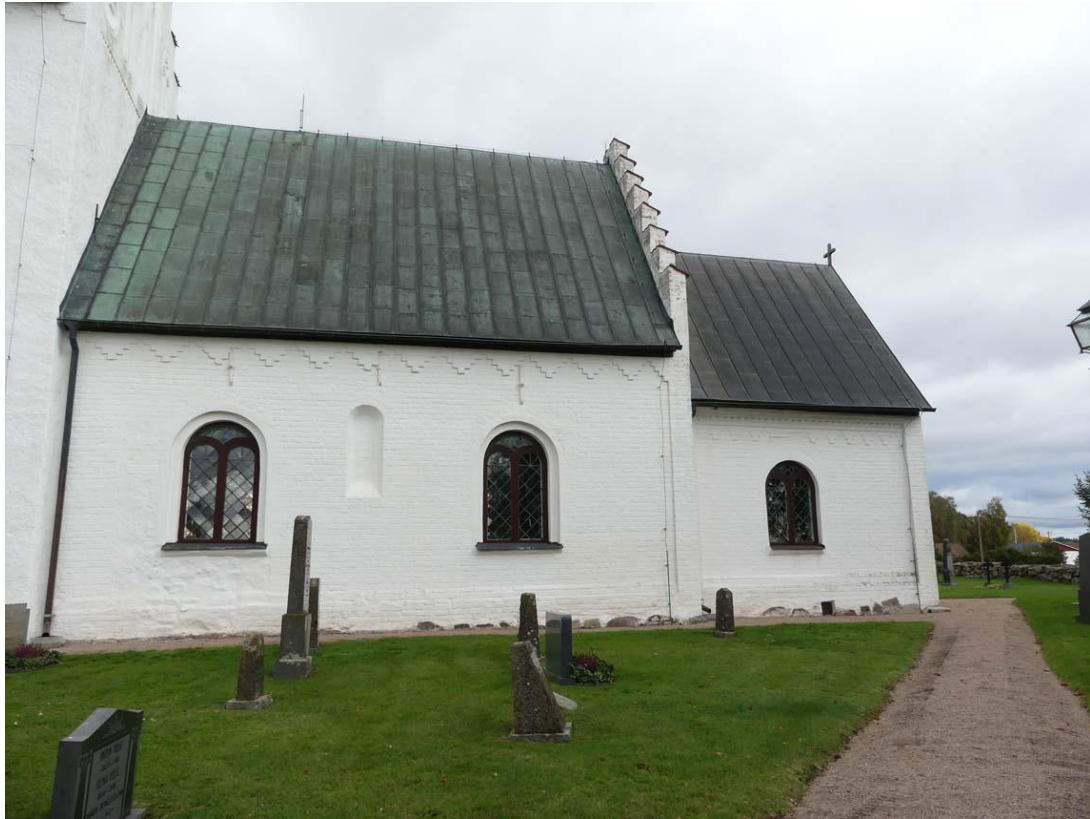
Den romanska delen av kyrkan sedd från söder. Ursprungligen fanns två fönster i långhusets södra vägg, öster om sydportalen. Fasaderna var oputsade och yttertaket av bly. Långhusets trappstegsgavlar är sekundära.
