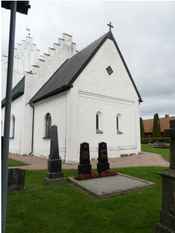
Koret är rakt avslutat och med två ursprungliga fönster mot öster.
