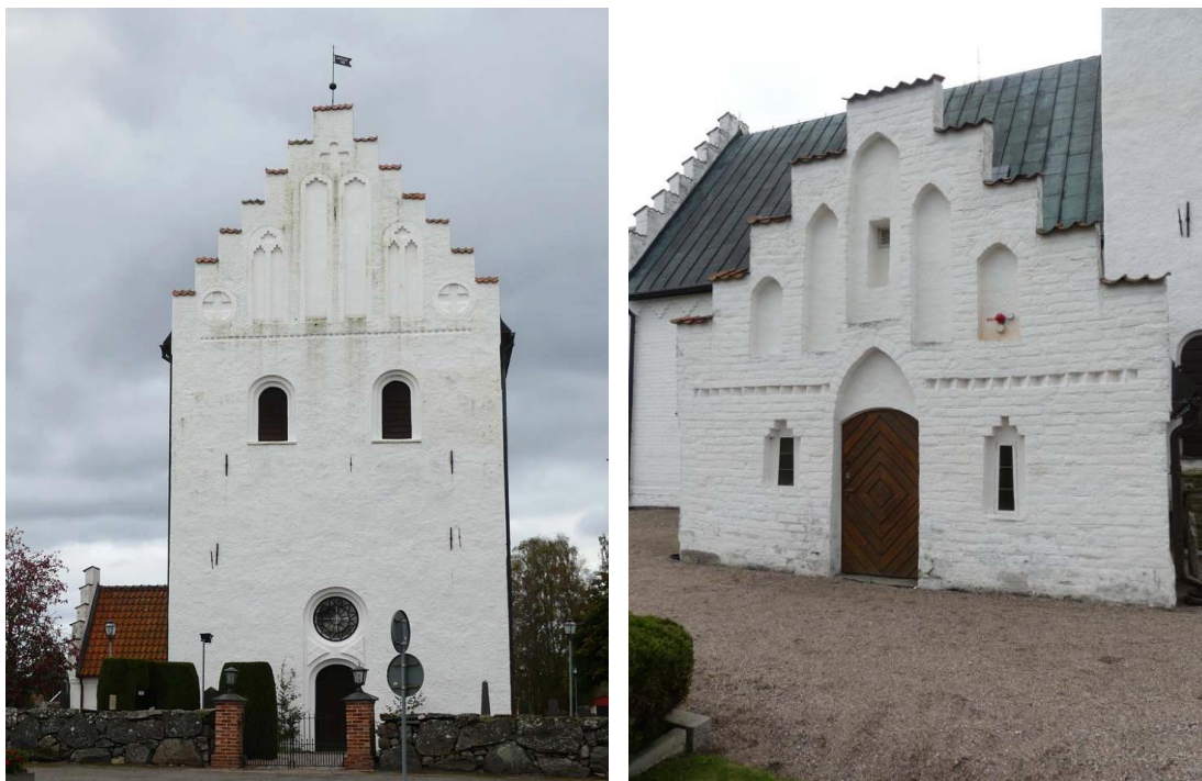
Tornet byggt 1850 sett från väster samt det medeltida vapenhusets norra fasad.
