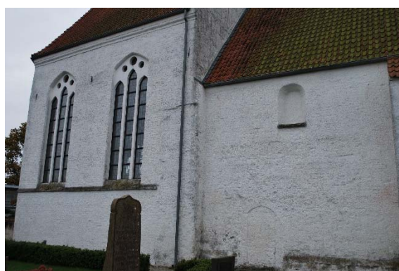
Korfönster och igensatta öppningar mot norr.
