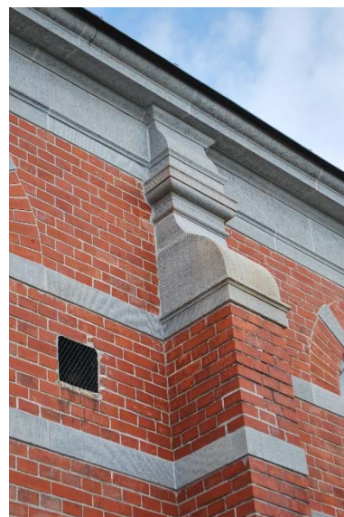
Detalj, kalksten på strävpelare.
