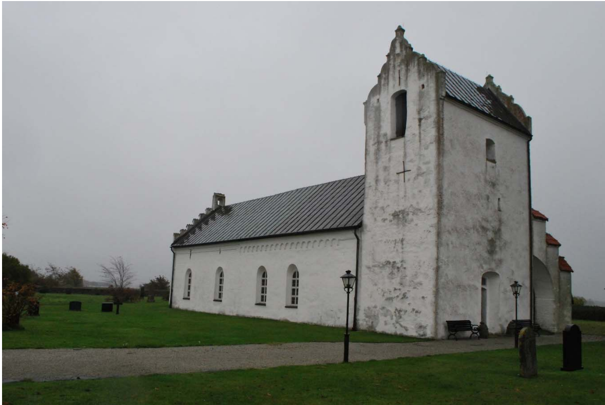
[2]: Kyrkobyggnaden från nordväst
