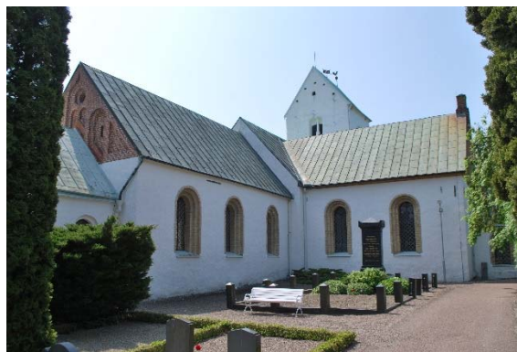
Fasad mot nordöst.
