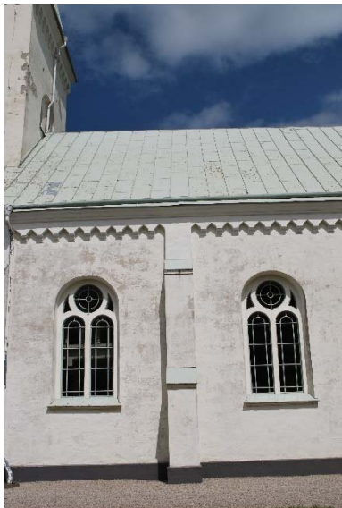
Fönster i långhuset.
