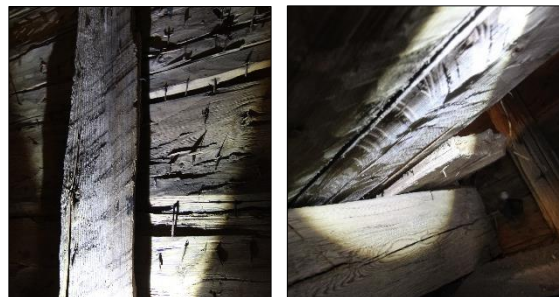
En medeltida bräda spikad som stöd åt panelen mellan stommens hörnstolpar (t.v.). Detaljbild av medeltida behuggning i släpljus på några av golvplankens undersidor (t.h.).
