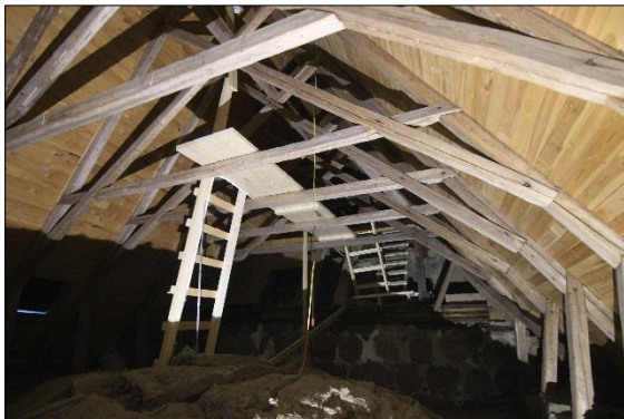
Takstolar över sakristian, sett från norr.
