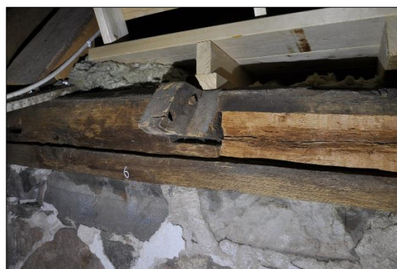
Bilden visar korets remstycke fotat från den senare tillbyggda sakristians vind. Remstycket har en utvändig fals för en tidigare takfotsbräda. Den utstickande delen av f.d. bindbjälken har en lutande undersida som visar på att takfotsbrädan varit uppvinklad.
