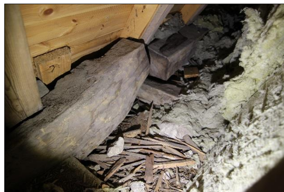
Styrbjälkar utmed norra murkrönet närmast högbenen.
