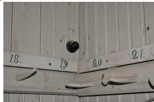
Bild 12. Rum 102: Omklädningsrum. Detalj av klädkrokar och äldre elinstallation. Foto Daniel Olsson, Länsstyrelsen Gävleborg 2018-09-06.
