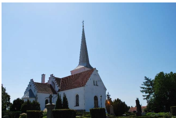
Fasad mot nordöst.
