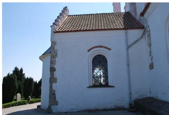
Koret, fasad mot norr, frilagd hörnkedja.
