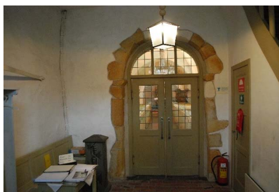
Portal i vapenhuset.
