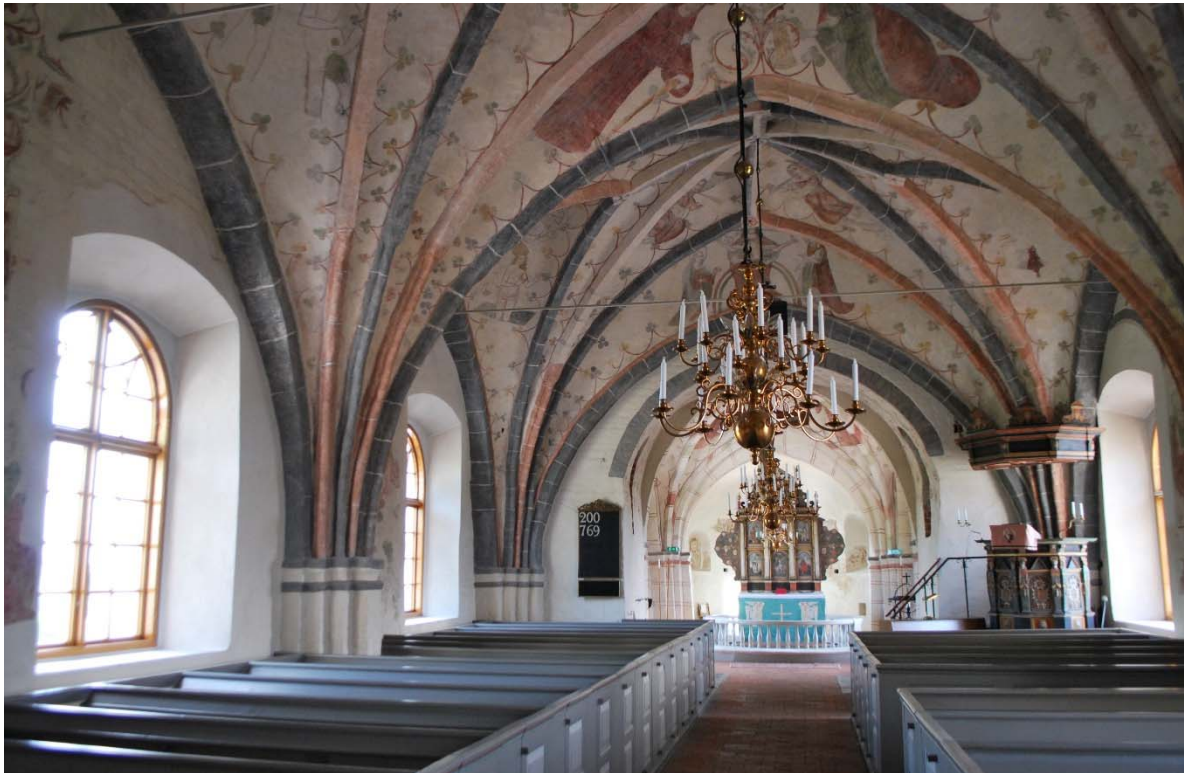
Långhuset mot koret i öster.
