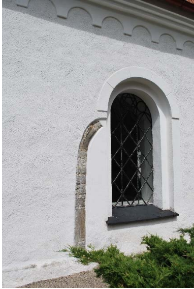
Rester av f.d. portal.
