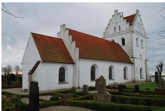
Fasad mot nordöst.
