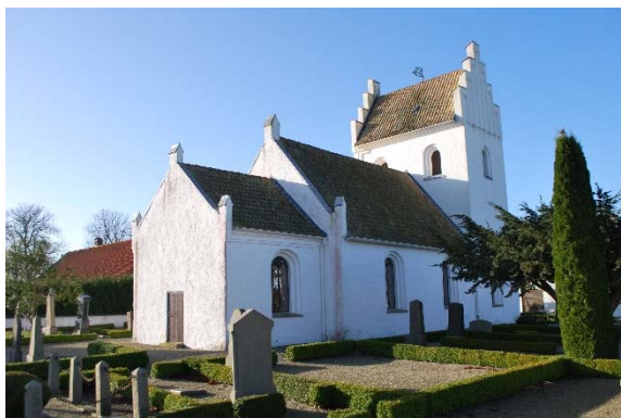
Fasad mot nordöst.
