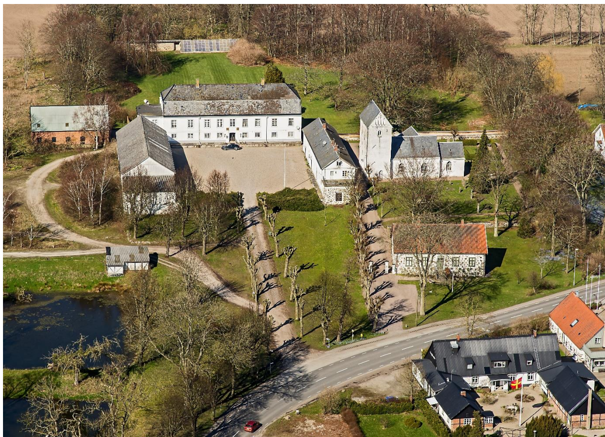
Flygbild över Stora Herrestads kyrkoanläggning från söder med säteriet, tingshuset samt gästgivargården i bildens nedre högra hörn. Foto: Pär-Martin Hedberg, 2014.
