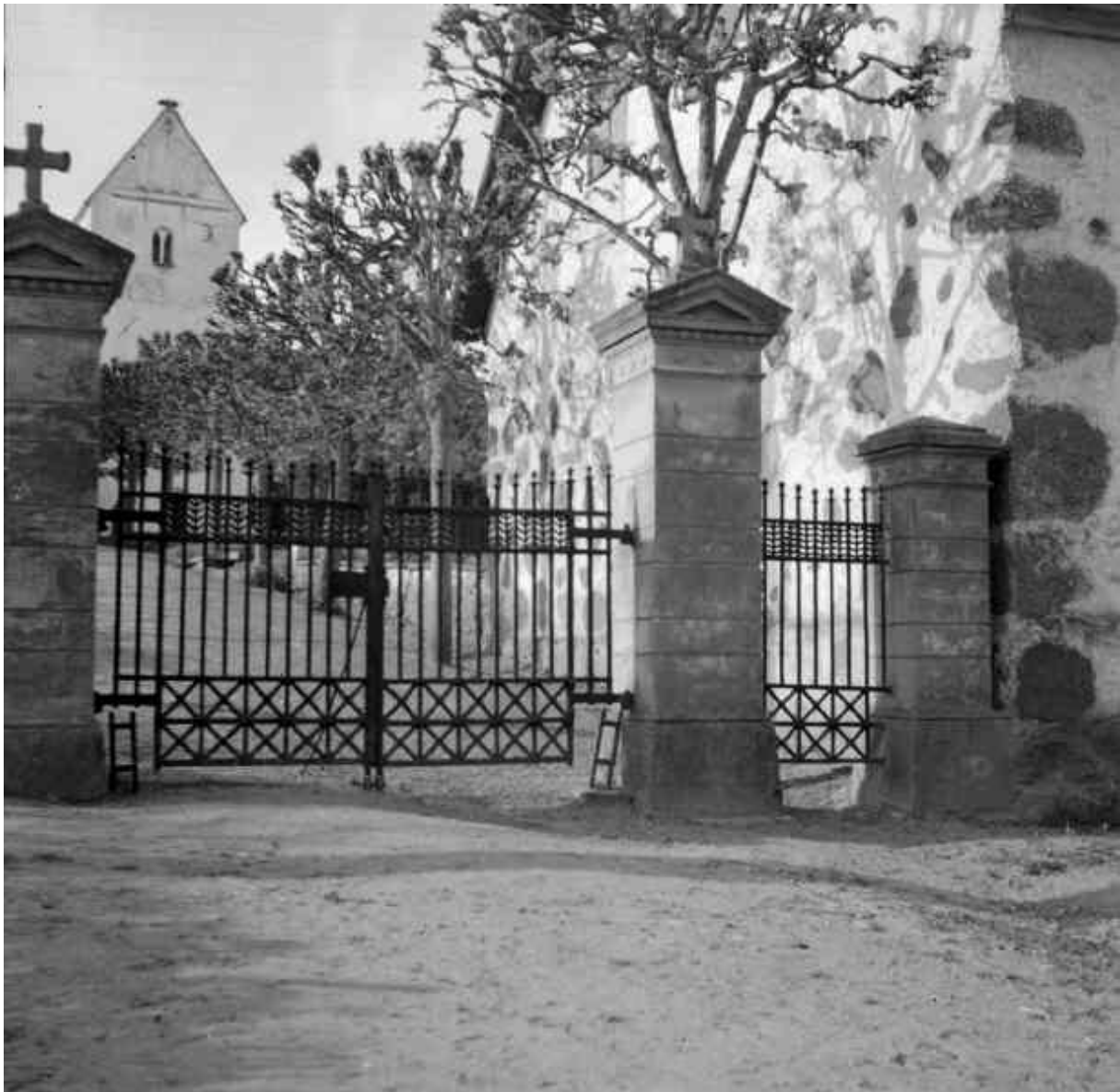
Foto: Erik Lundberg, 1942. Bilden är hämtad från Riksantikvarieämbetets bilddatabas Kulturmiljöbild.
