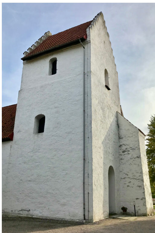
Tornet med västentré och kraftig strävpelare i sydväst.
