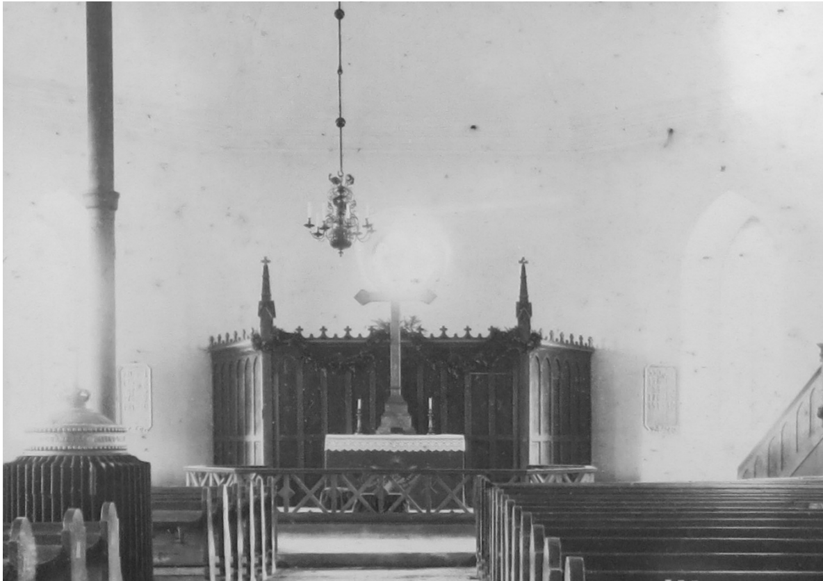
Vanstad kyrka med nygotisk altarinredning fotograferad någon gång mellan 1874 och 1904. Bild från ATA, fotograf: B.A. Lindgrens förlag, Lund.
