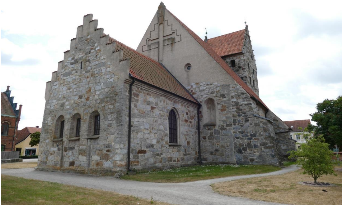
S:t Nicolai kyrka med koret i förgrunden. Koret är den äldsta delen av byggnaden, därefter kommer långhus och vapenhus och till slut tornet.
