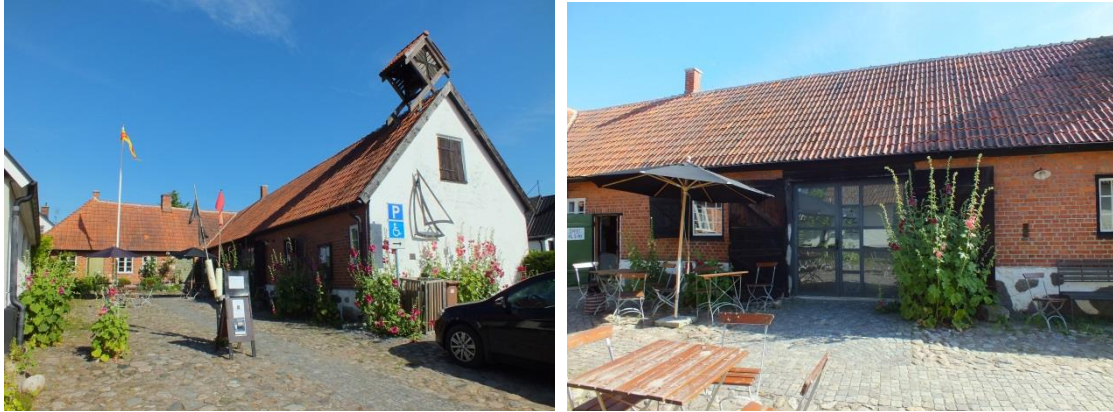
Skillinge kapell med f.d. bostadslänga till vänster och kapellet till höger. Den högra bilden visar delar av kapellets södra fasad där metalledörrar med frostade glas bildar ljusinsläpp i lokalen.
