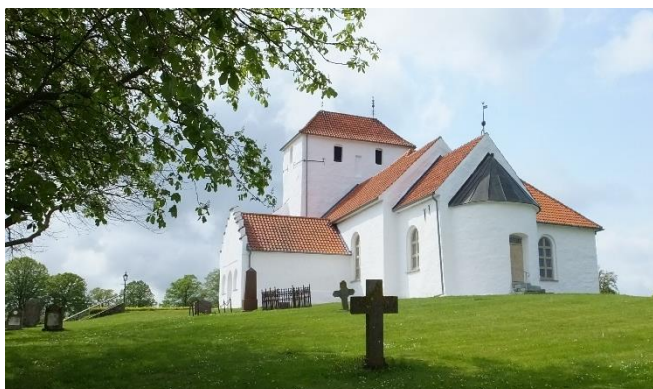
Kyrkan sedd från sydost.
