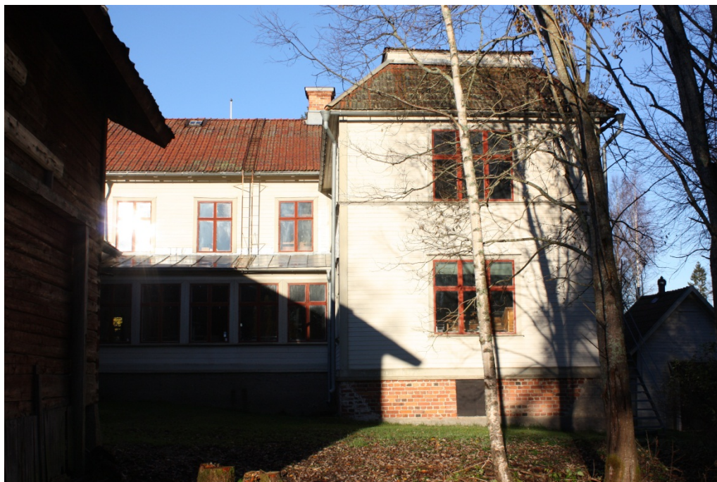
Tillbyggnaderna vid tryckeriets baksida vittnar om rörelsens utveckling. Sätteriet från 1909 framhävs genom sin ambitiösa takutformning i nationalromantisk stil.
