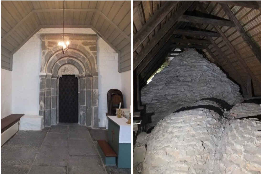
Bilden till vänster visar sydportalen i södra vapenhuset och högra bilden visar ovensidan till korförlängningens valv samt gaveln till det gamla koret med dess tak av kalkstensflis under taklaget från 1900-talet.
