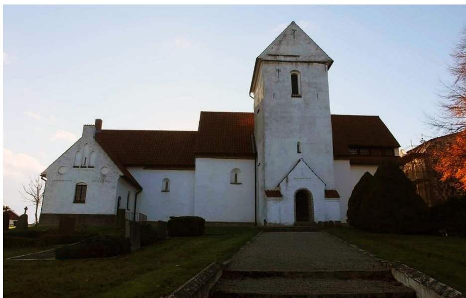
Kyrkan sett från norr. Från vänster till höger syns sakristian utanför korförlängningen, det romanska koret och långhuset, klocktornet, det romanska torndelen och 1914 års västförlängning.
