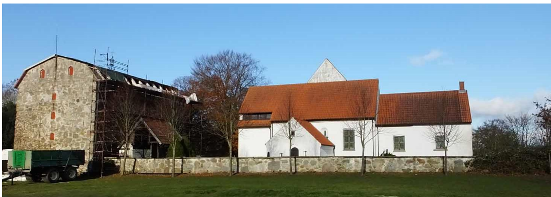
Kyrkan och stenmagasinet sett från söder.
