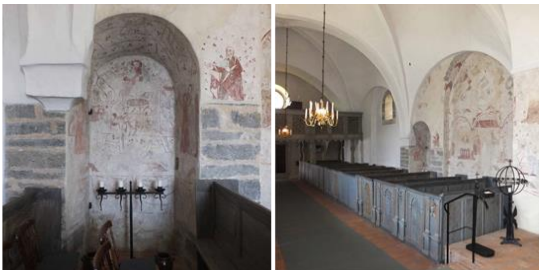
Nordportalens inre smyg samt långhuset sett mot nordost.
