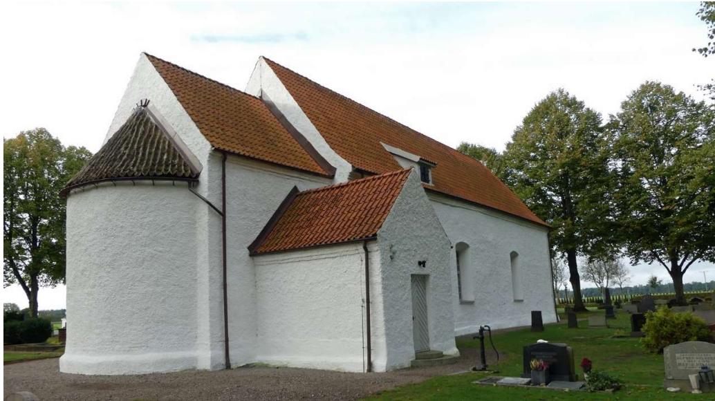
Kyrkan från nordost. De östra delarna av långhuset, det lägre och smalare koret samt absiden bedöms vara ursprungliga, från senare delen av 1100-talet. Absiden har en ålderdomlig taktäckning med understruket nunnetegel. Långhusets västra del byggdes till på 1830-talet och sakristian tillkom sannolikt kring sekelskiftet 1900.
