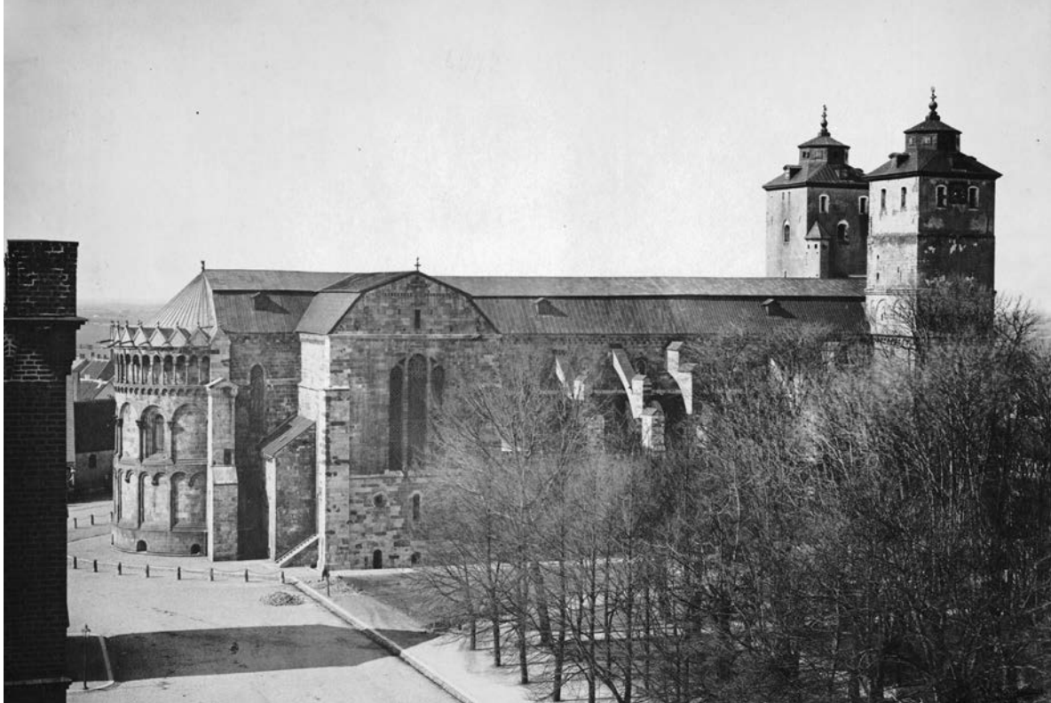
Domkyrkan innan Zettervalls ombyggnader, med strävpelare, mansardtak och tornhuvar med lanterniner. Ur C.G. Brunius samling, bild från Forndok.
