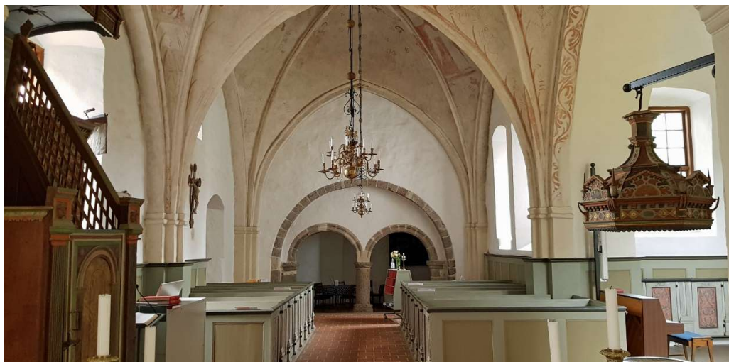
Utblick från koret mot tornets bottenvåning i väster.
