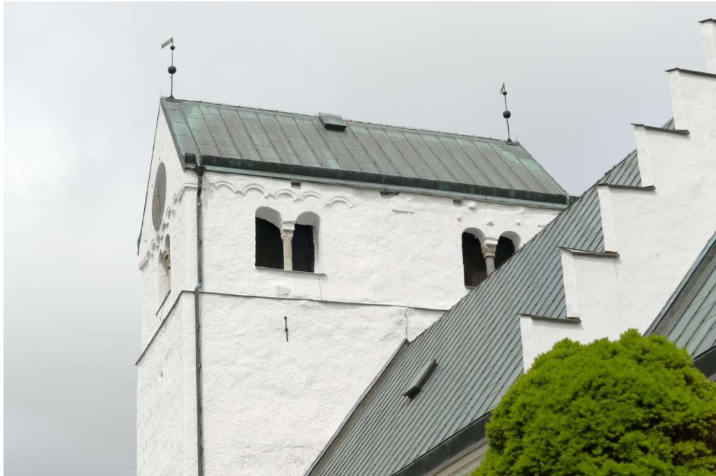
Tornets södra och östra fasader. Västtornet är bredare än långhuset men sannolikt uppfört vid samma tillfälle. Stenarbetena i ljudluckor och rundbågefrisen är påkostade och tillskrivs Carl Stenmästare. Tornuret med urtavlor i tre väderstreck installerades kring år 1800.
