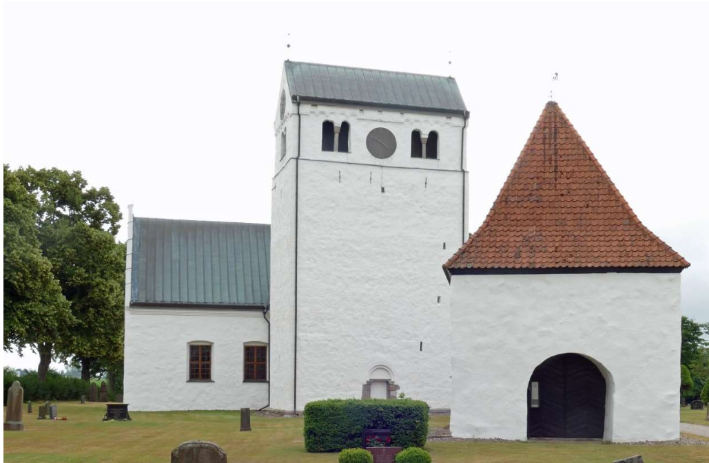
Kyrkans västra fasad med det romanska tornet och den norra korsarmen som uppfördes 1763. I förgrunden till höger syns en medeltida byggnad, det så kallade porttornet, vars ursprungliga ålder och syfte är okänt.
