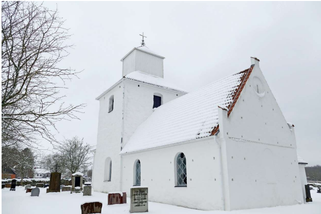
Kyrkan från sydost. Det medeltida gavelpartiet har tinnar vid takfot ochnock, ett horisontellt strömskejt och en rund nisch med avlång muröppning i övre gaveln. Bombhål är spridda över fasaden samt över delar av södra långhusfasaden. I gavelväggen finns även spår av ett rundbågigt fönster.
