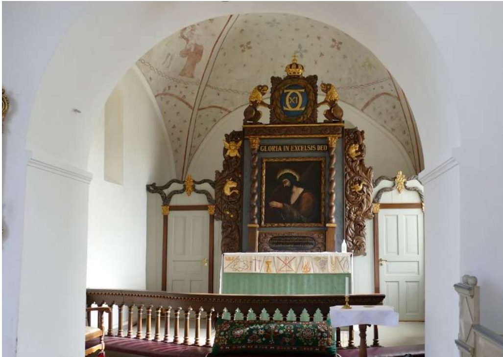
Koret har sitt ursprungliga romanska valv från 1200-talet bevarat. Här finns också nischer efter medeltida fönster åt norr, och bakom altaret finns nischer efter en ursprunglig trefönstergrupp.
