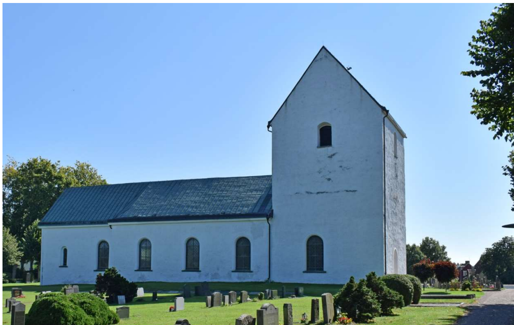
Önnestad kyrka från norr. Till vänster i bild syns koret, som är något smalare än långhuset till höger om detta. Tornet i väster är lika brett som långhuset.
