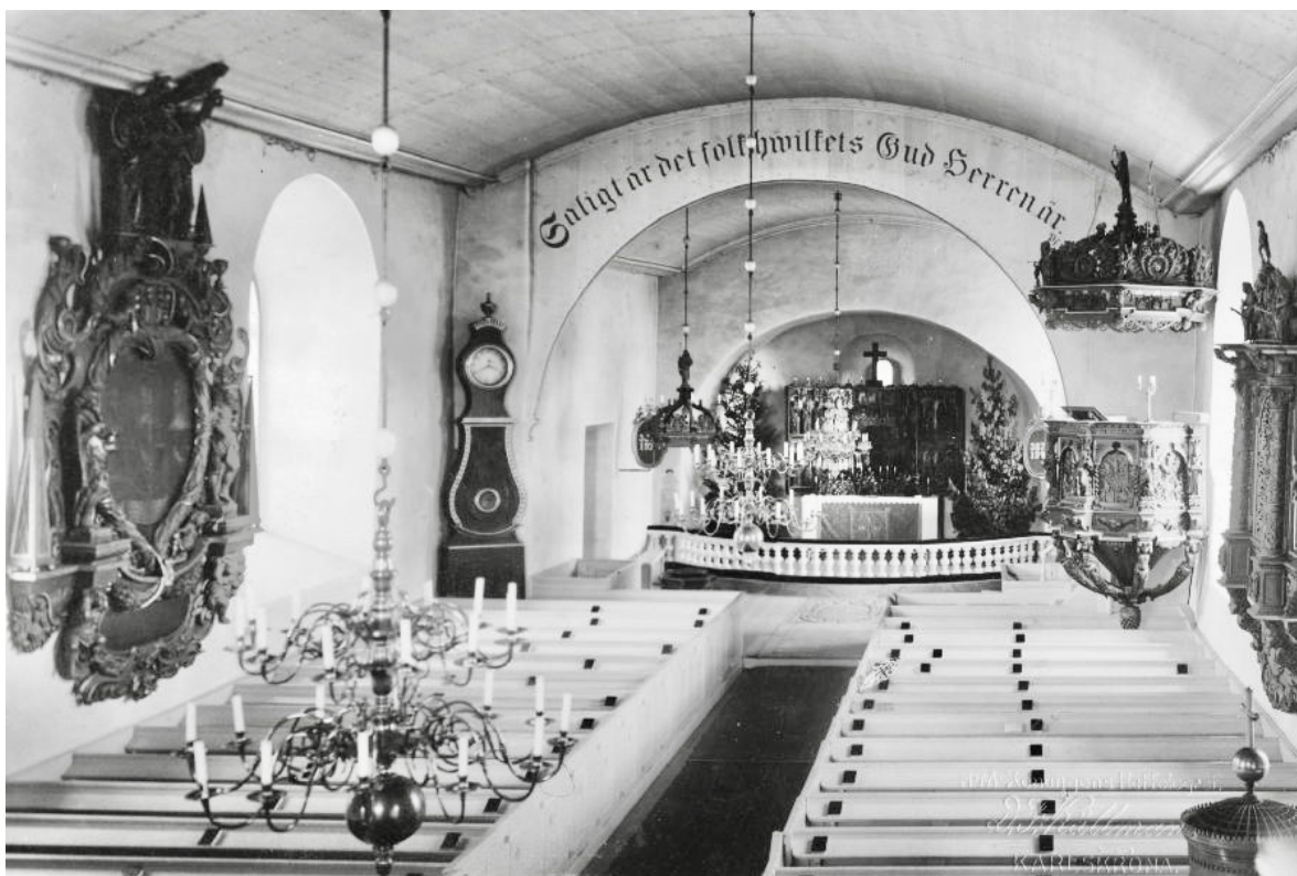
Interiören fotograferad någon gång omkring 1930. I absiden står det medeltida altarskåpet som idag finns i Sillhövda kyrka och innertaken utgörs av stickbågiga trävalv. Till höger skimtar en av de två värmeugnar som var placerade i långhusets bänkkvarter. Bild från ATA, fotograf okänd.
