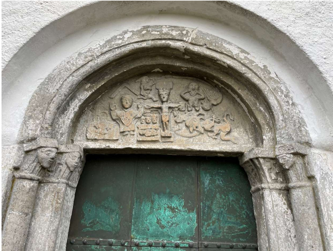
En ursprunglig portalomfattning har flyttats till kyrkans västra sida och utgör huvudentré.
