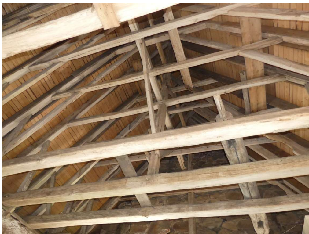
Torntaklaget består av ett till stora delar intakt medeltida taklag av ek.
